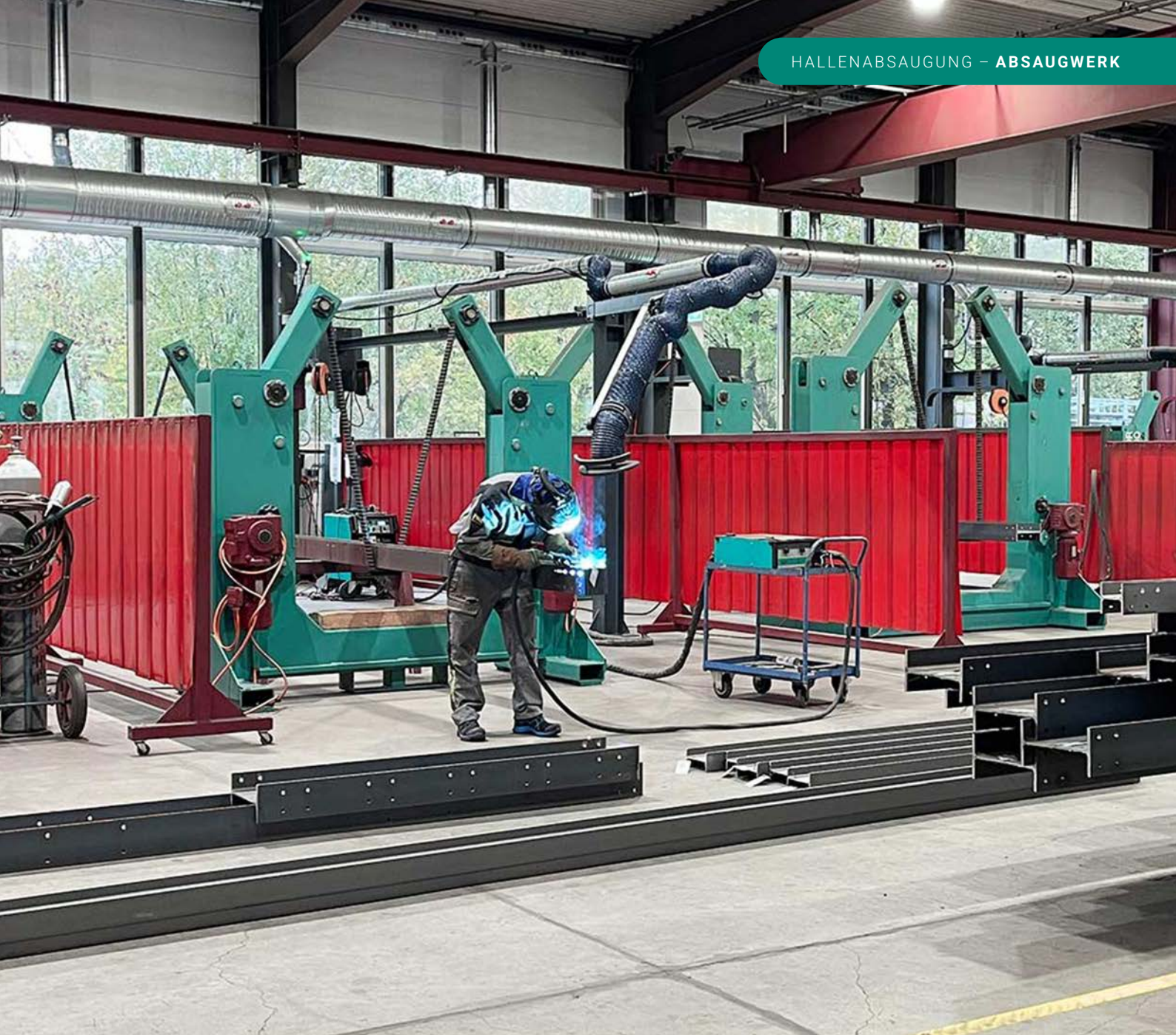
Direktabsaugung über Absaugarme in Kombination mit zentraler Hallenabsaugung
