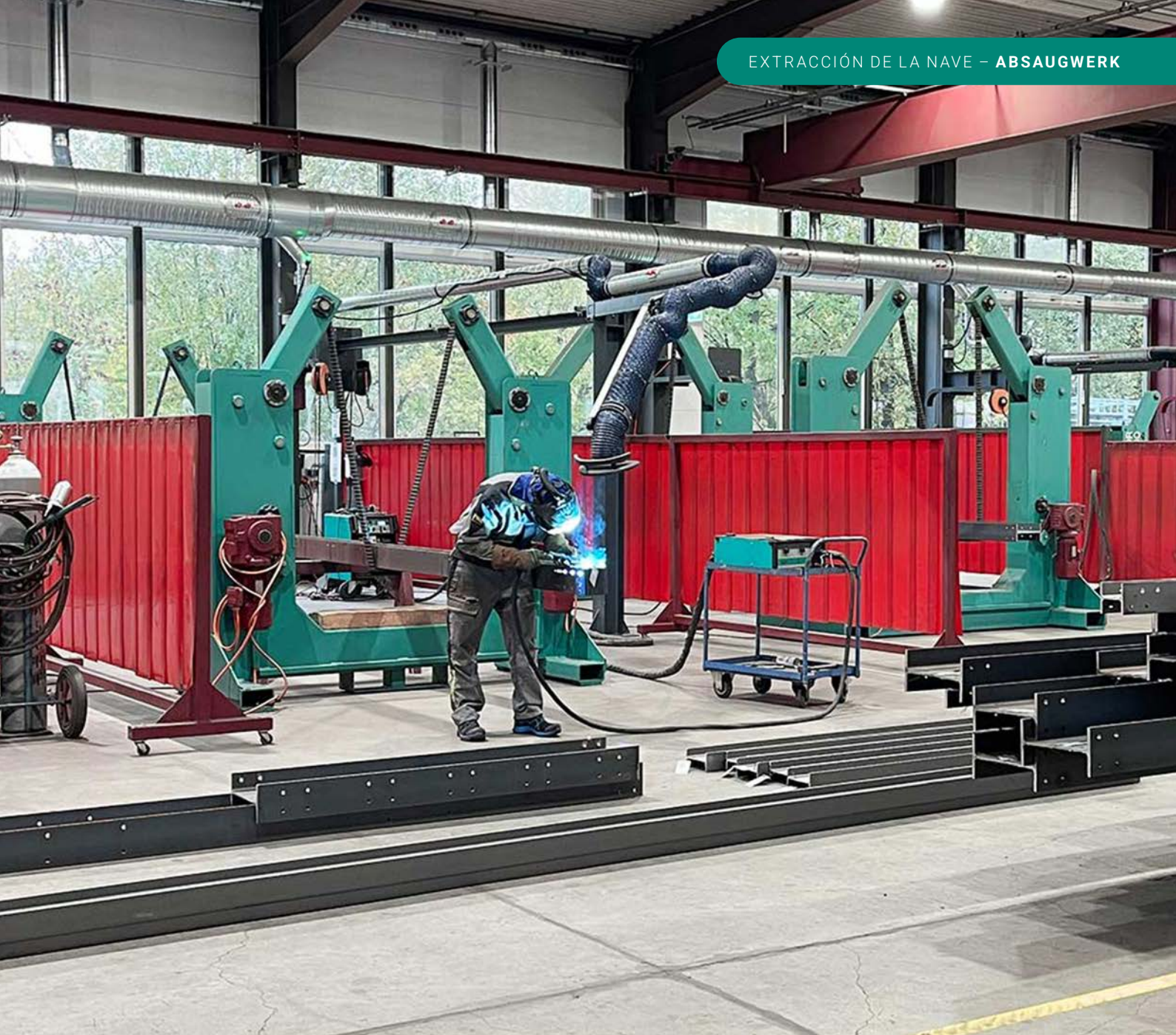
Aspiración directa mediante brazos de extracción en combinación con extracción central en naves
