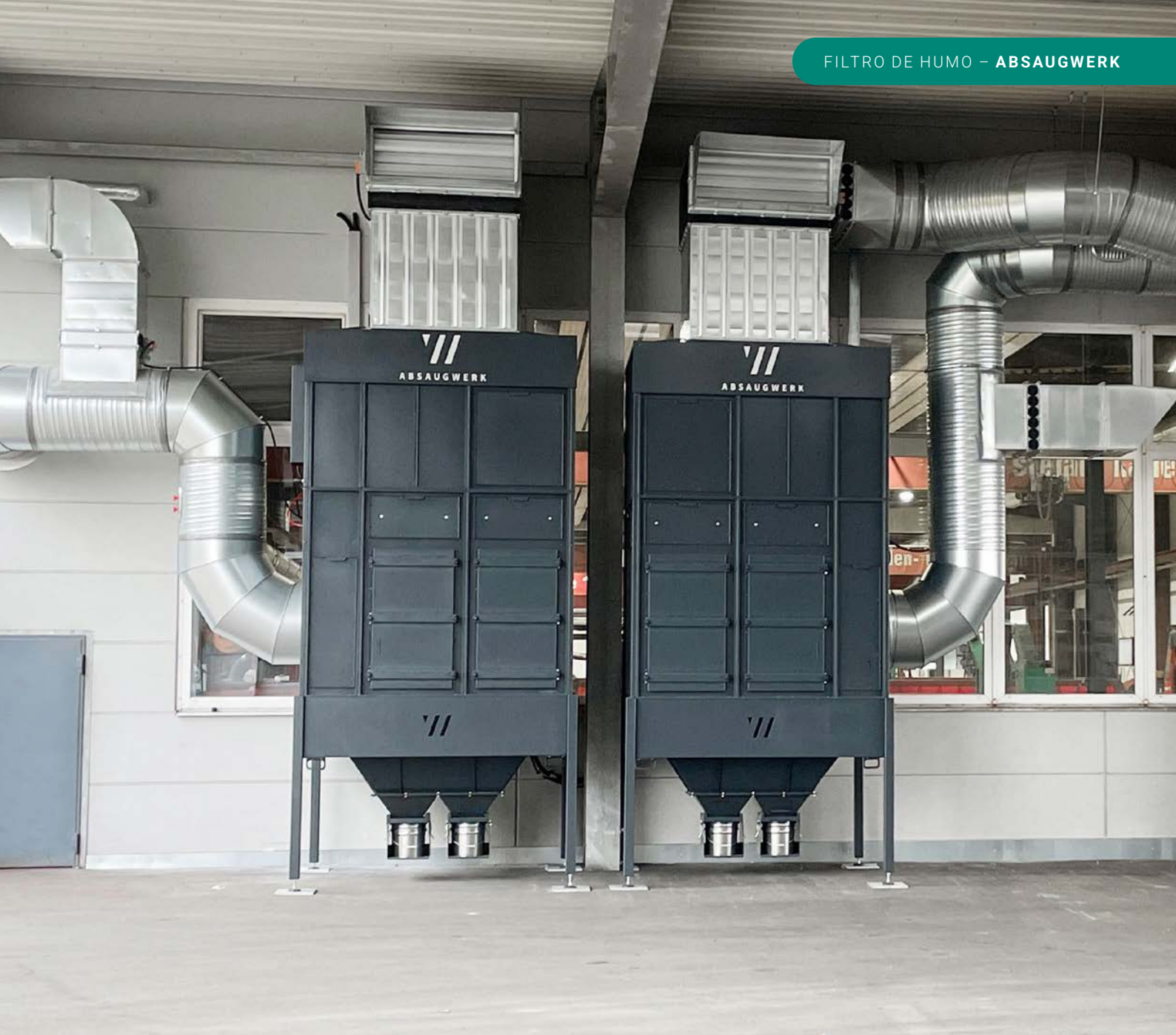
Filtros de humo serie 7000 en configuración doble con 37 kW de potencia cada uno
