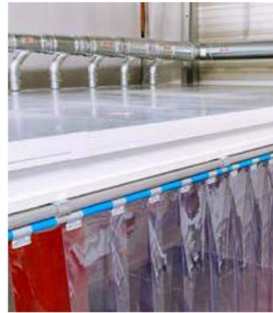
ROHRANSCHLÜSSE VON DER KABINE ZUR ABSAUGANLAGE
